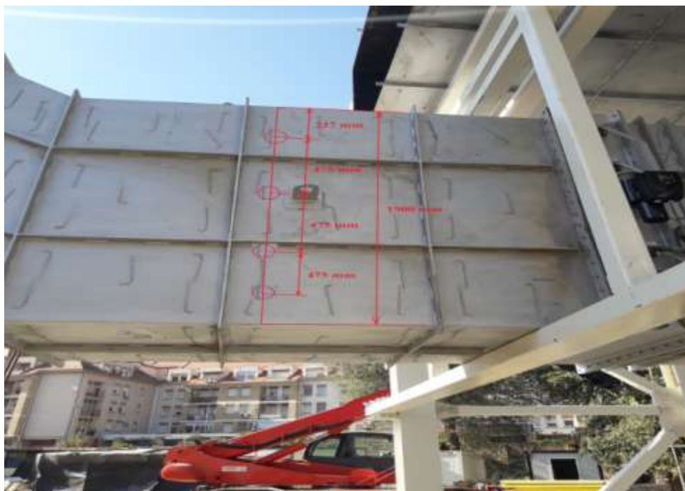
Slika A 2.2 Merna mesta za merenje dimnog gasa na bilansnoj granici
