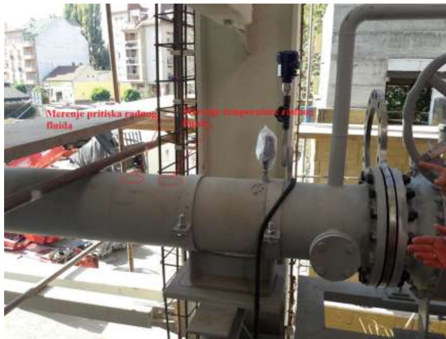
Slika A 2.5 Merno mesto za merenje temperature radnog fluida na ulazu u bilansnu granicu
